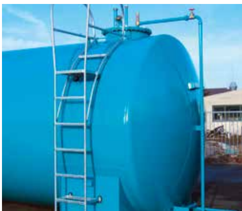
Dieseltank mit Podest und Saugleitung
